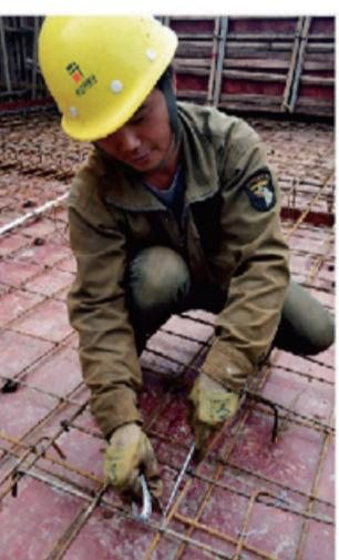
“安全、质量一刻都不能放松”。钢筋工人正一丝不苟的检查已经铺设了的钢筋，根据施工图纸校对是否放置正确，正确后再仔细用铁丝固定钢筋位置。每天从早上7点多，一直到晚上7点多，在工地上一待就是10多个小时。腰压弯了，满脸汗水，一身脏兮兮，但还是脸上带笑。为了赶工期，加班加点已经成为常事，但是为了工程的进度和质量的要求，他们依然坚持着。
